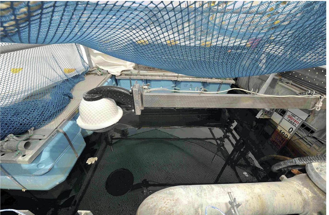
5階フロア……使用済み核燃料プールがあった。がれきがプール内に落ちないように、水面を浮き板で覆っている。監視カメラがある一面からは水面が見えた。7メートル下には1535体もの核燃料が眠る。水は写真で見るよりずっと暗くよどみ、中の様子はいかががえなかった。(5/27 東京新聞 1F 建屋内ルポより)
