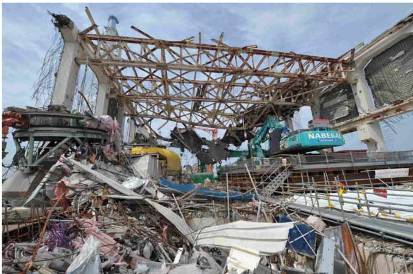
4号機の5階部分のオペレーションフロア。中央左側の黄色い球体状のものは格納容器の蓋=26日 13:52
