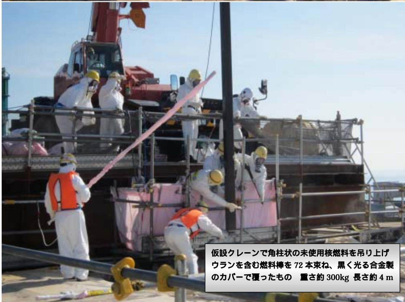
仮設クレーンで角柱状の未使用核燃料を吊り上げ
