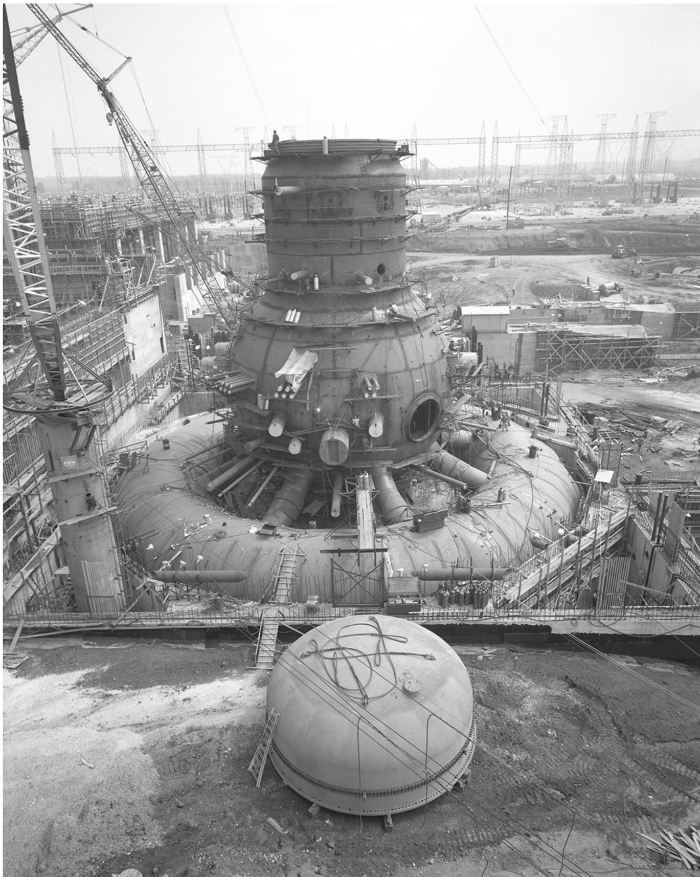
1F・1号機で使用されている原子炉格納容器（GE製 MARK1）と同型実物写真
